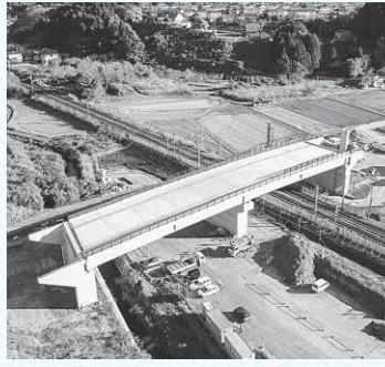
北町・関本中線こ線橋
