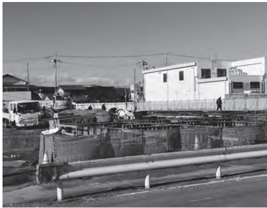
建設が進む、第2期子育て支援住宅(磯原町)
