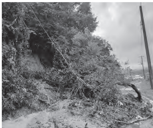
通学路土砂崩れ（中郷第二小学区）
