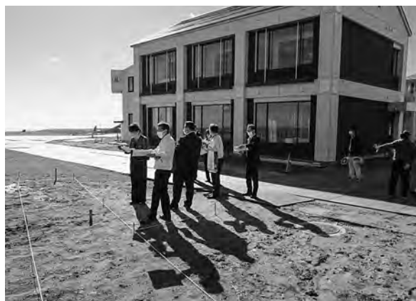
マウントあかね展望浴室棟新築予定地(12月14日撮影)
