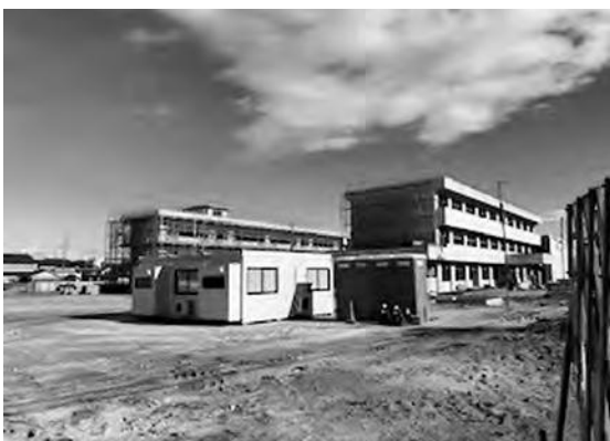
●解体工事が進む旧磯原中学校（2022年1月）
