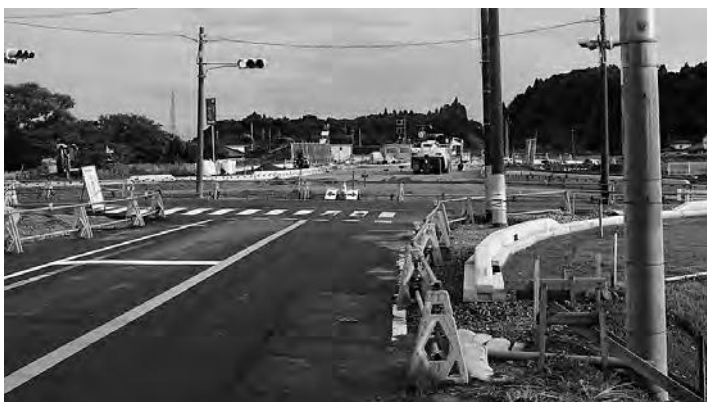
高萩・北茨城二市幹線道路工事（中郷町・2021年6月）
