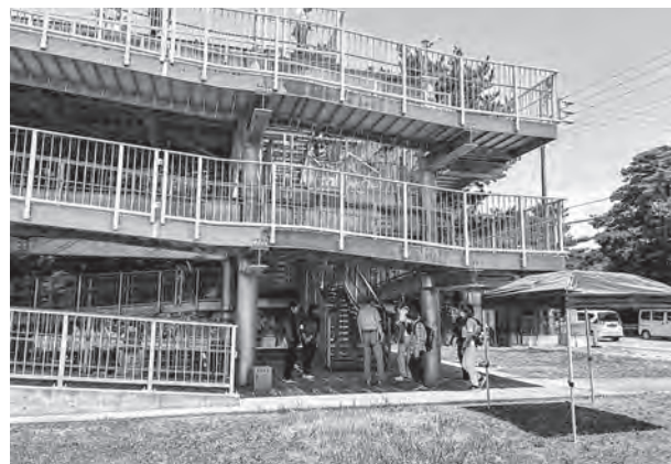
津波避難タワーへ避難する様子 (中郷町下桜井地区)
