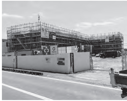
建設中の子育て支援住宅「トリシア磯原」
