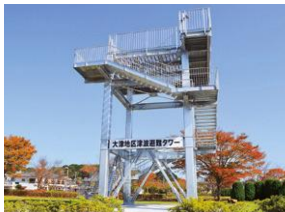
津波避難タワー
