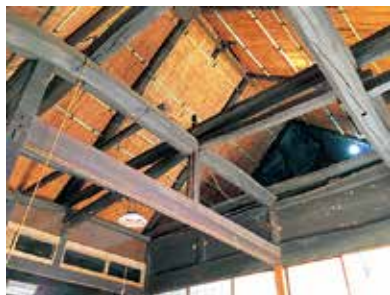
▲天井の抜かれた吹き抜けが清々しい。
