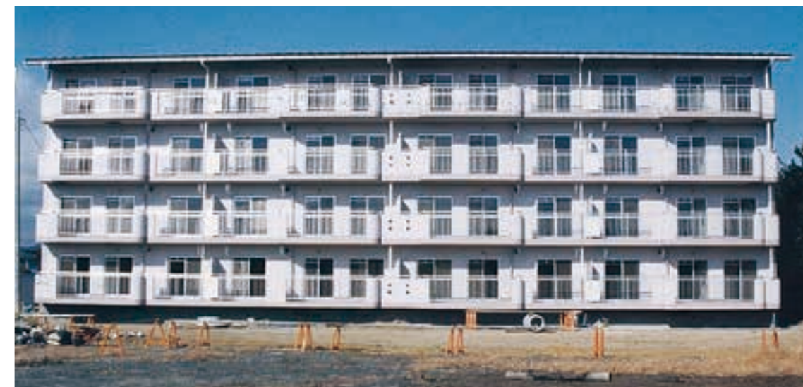
完成した下桜井市営住宅1号棟 (平成10年)
