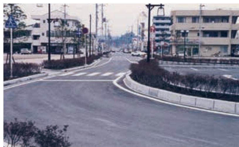
整備が進む磯原駅西口付近 (平成10年)
