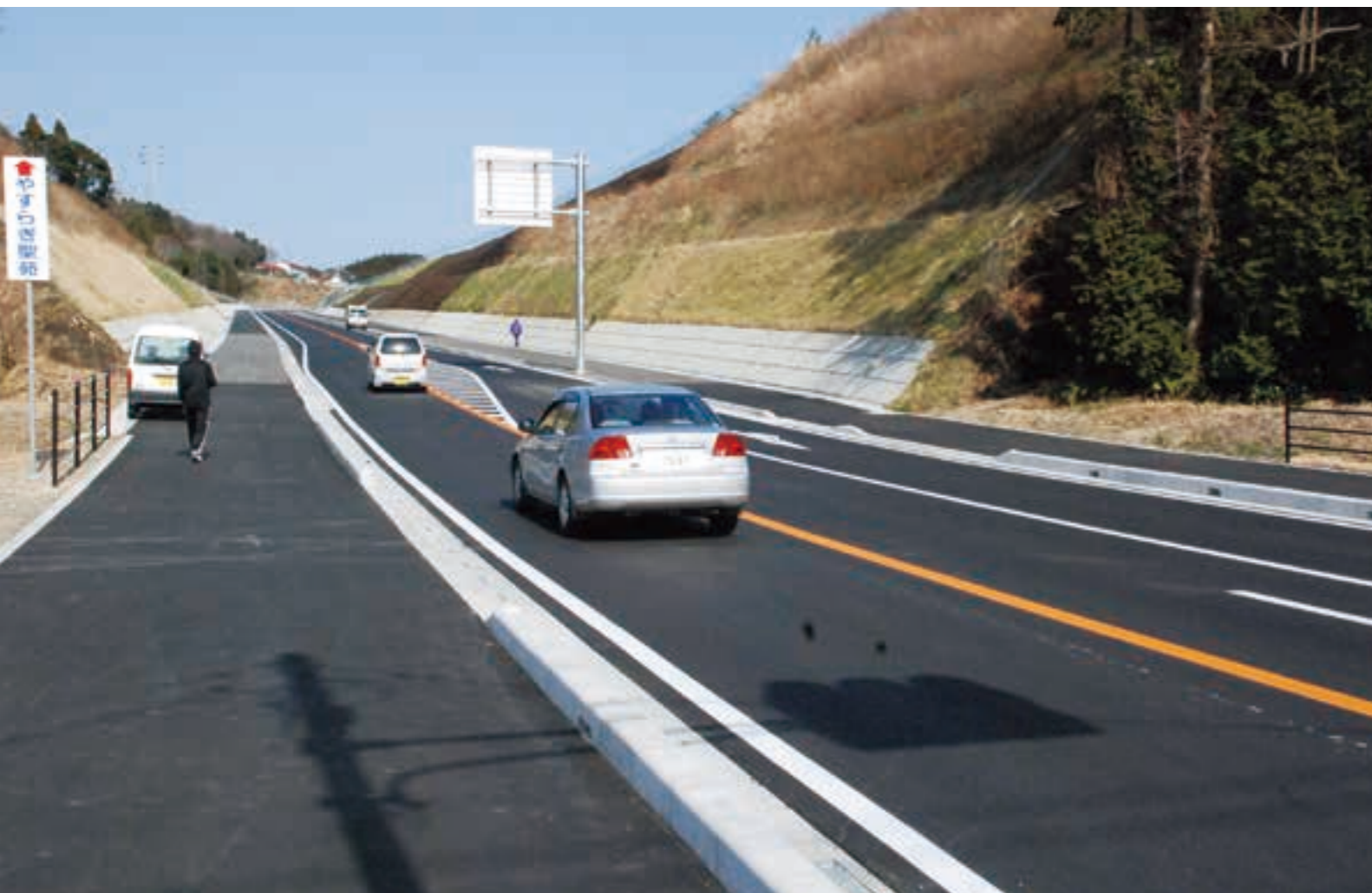
市道豊田・下駒木線が開通 (平成21年)
