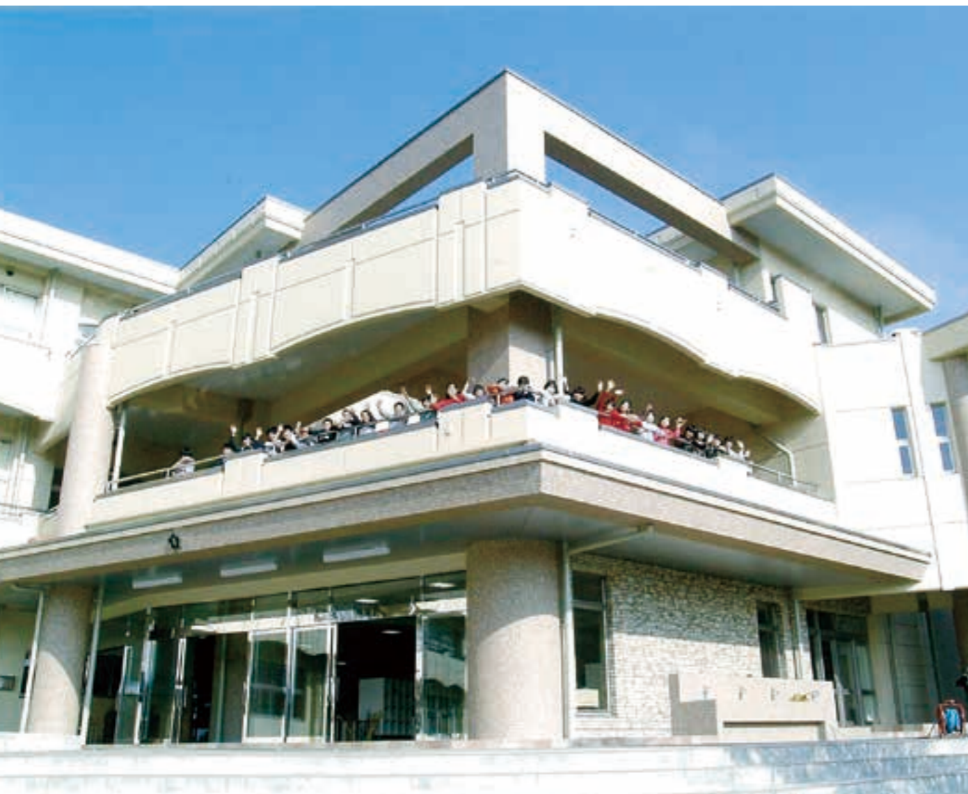
明德小学校新校舎が完成 (平成16年)
