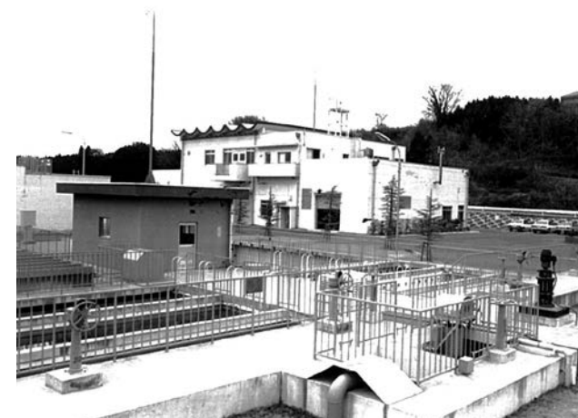
中郷浄水場が完成（昭和57年）
