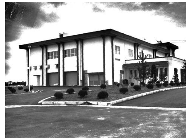
完成した環境センターが稼働開始（昭和59年）
