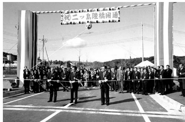
ニッ島陸橋が完成（昭和56年）
