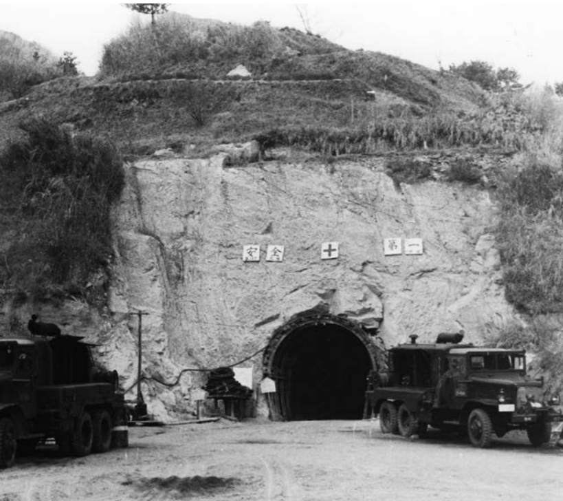
工事が進む現在の国道6号平潟トンネル (昭和35年)
