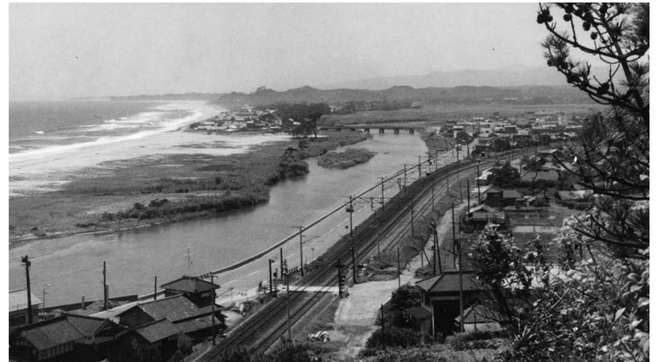
昭和40年頃の磯原。大北川沿いに常磐線、国道6号が走る
