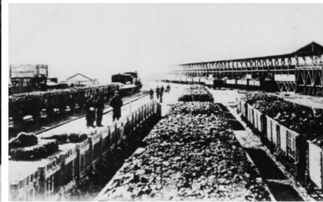
茨城採炭の磯原駅石炭積み込み場
