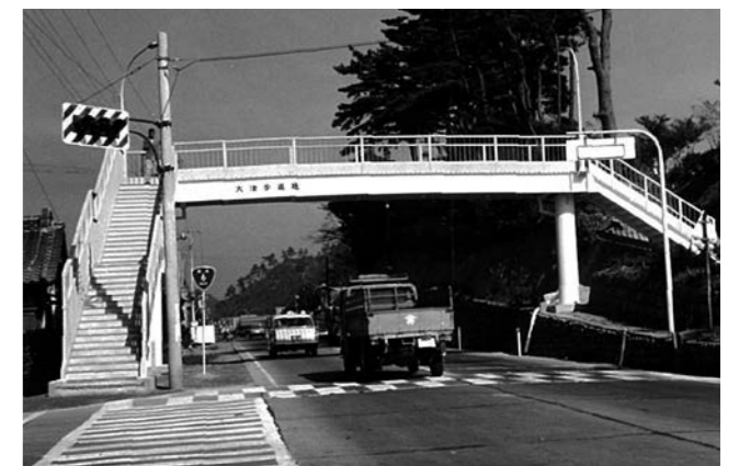
常北中学校下に立体歩道橋が設置される (昭和42年)
