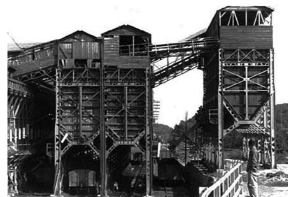
昭和30年代の中郷炭鉱の選炭と積み出しポケット
