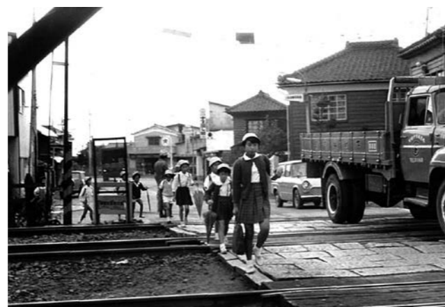
立体橋と跨線橋が完成し、閉鎖されたことになった磯原踏切 (昭和43年頃)
