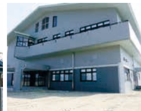
北茨城浄化センター(下水道)が供用開始 (平成17年)
