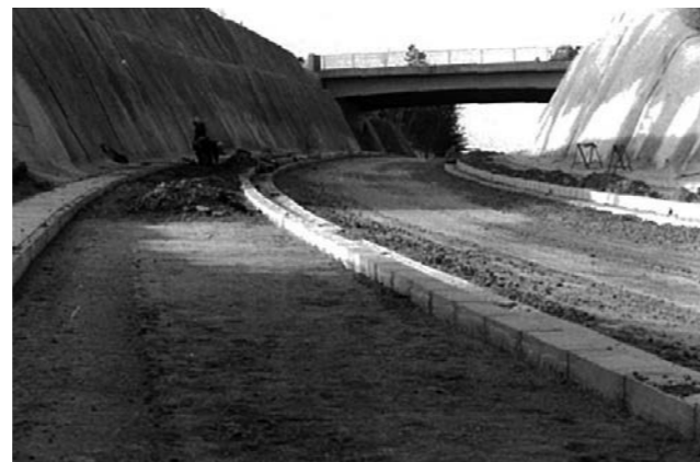
整備中の高萩磯原線汐見ヶ丘万作橋下（昭和55年）
