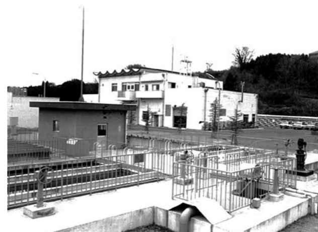
中郷浄水場が完成（昭和57年）
