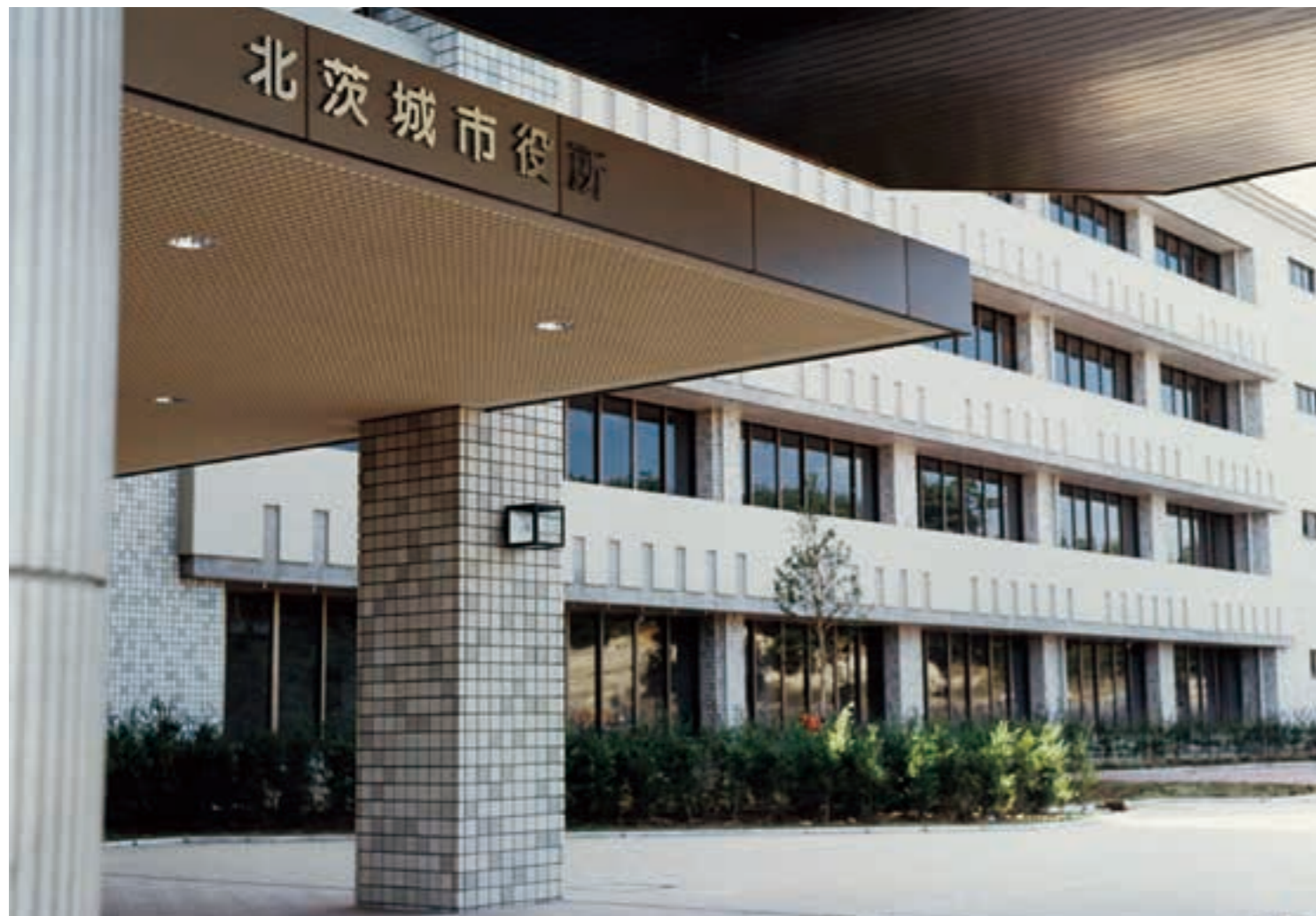
市民サービスの拠点となる北茨城市新庁舎が完成 (昭和62年)
