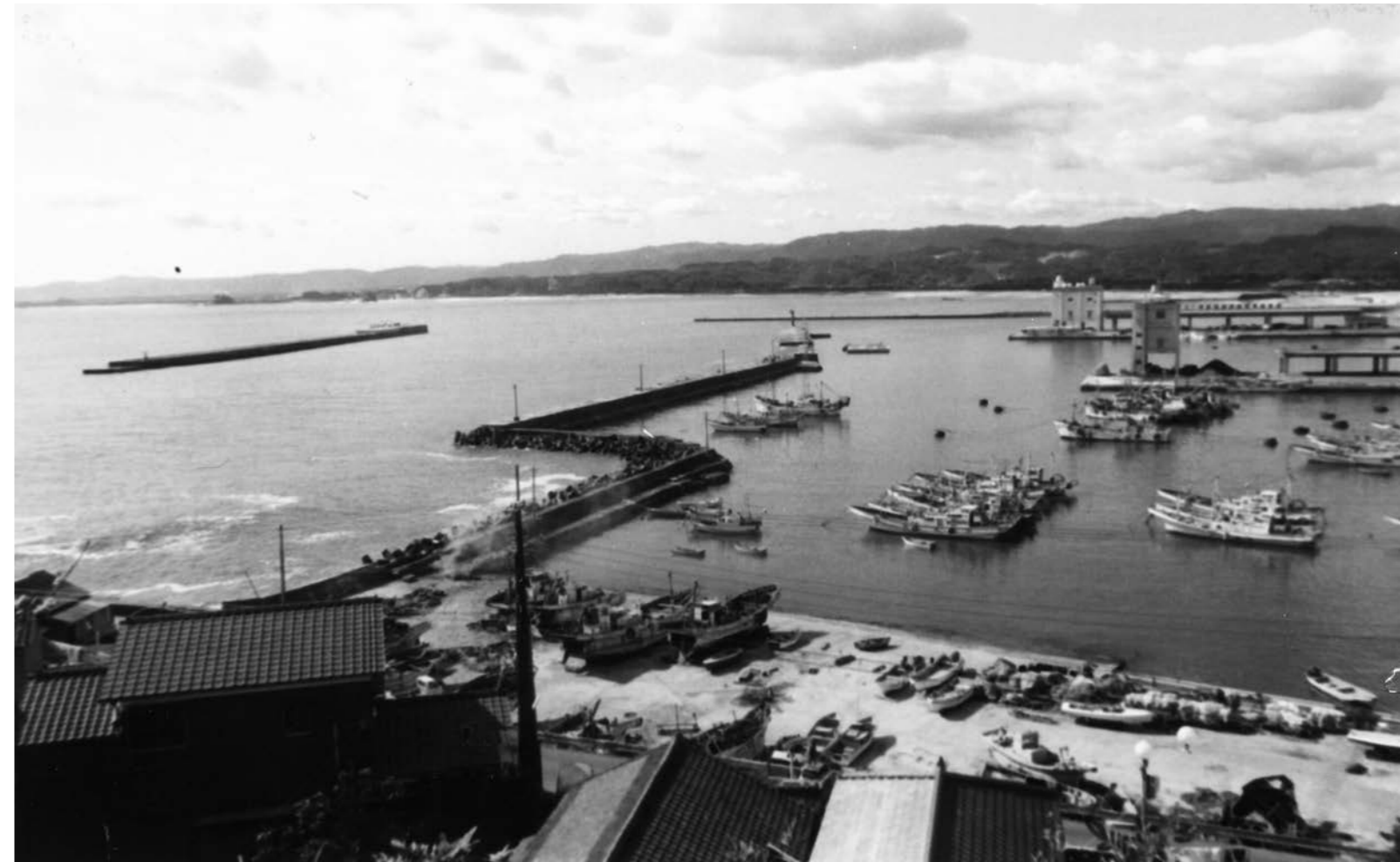
第7次漁業整備事業が着工となる大津漁港（昭和57年）
