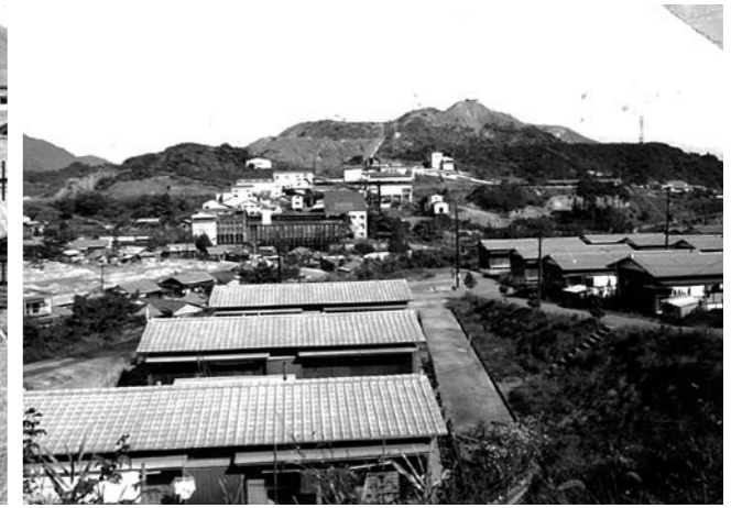
閉山後の常磐炭鉱中郷鉱 (昭和46年)
